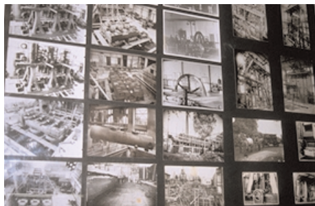
Bildcollage im Pumpwerk vom Bau der Anlage
